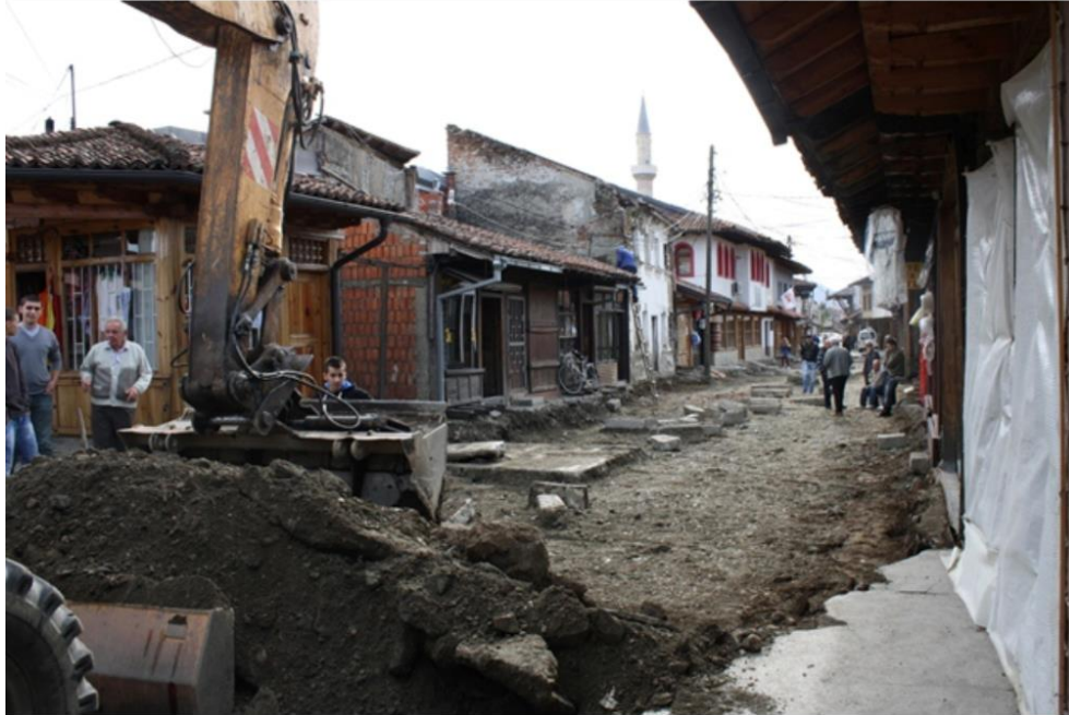
Figura 8 - Qarshia e rrënuar në Gjakovë, gjatë luftës së fundit në Kosovë 39
